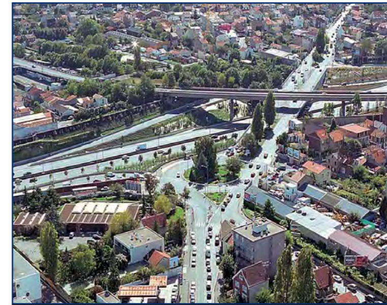
Le franchissement de l'A3
