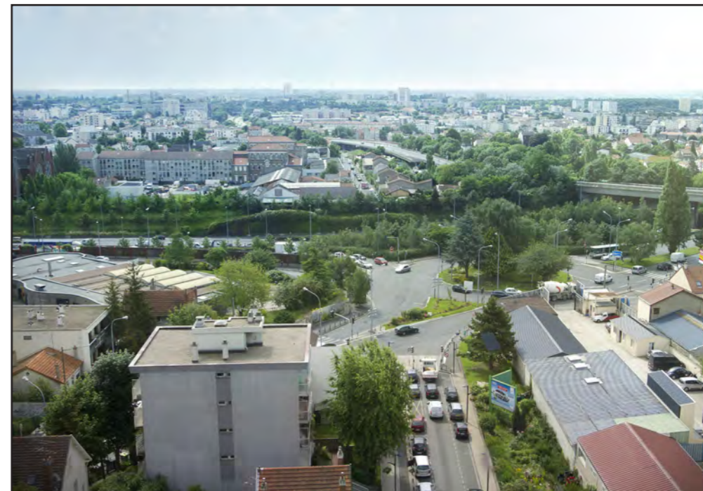
Vue du franchissement de l'autoroute A3
