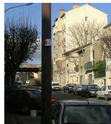
Point n°27 117, Rue de Romainville (Montreuil)
