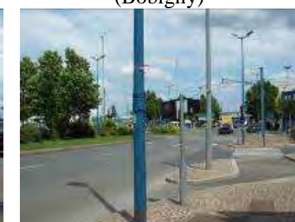
Point n°7 Croisement Rue de paris - Avenue Gallieni (Noisy-Le-Sec)
