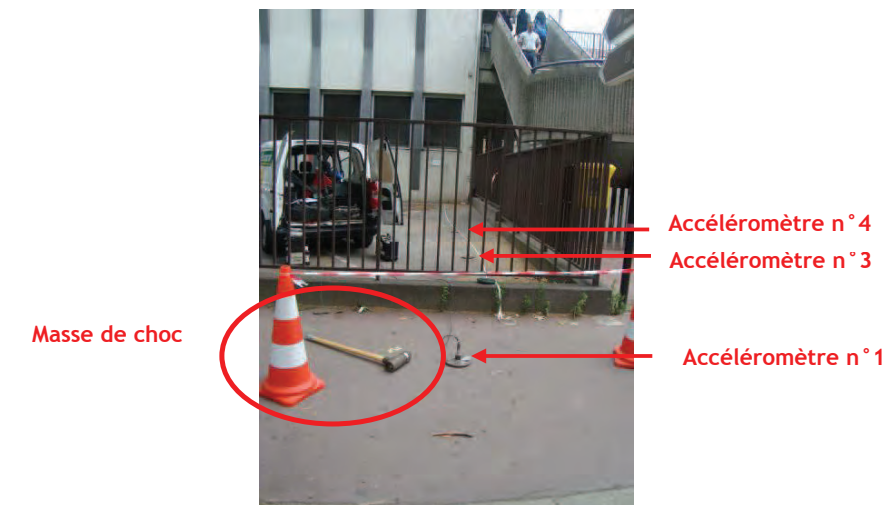
Photo 7 : Exemple de mesure de décroissance site n°4 : moyen d'excitation et accéléromètres
