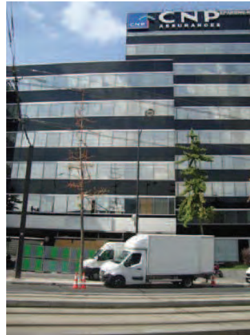
Photo 12 : Emplacement des mesures au passage
